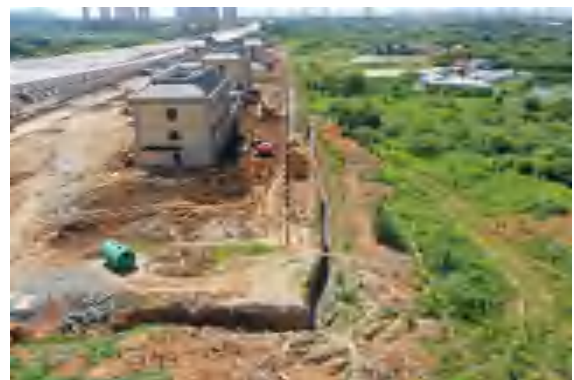
K1+000 主线收费站周边永临结合排水沟
