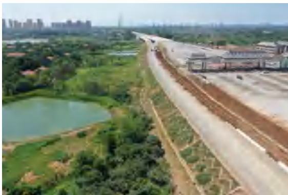
K0+200 路基边坡骨架植草防护
