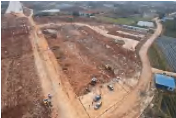
K15+000 预制梁场场地硬化层清除，土地整治
