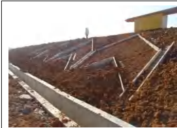
K0+400 路基人字形骨架护坡、混凝土排水沟
