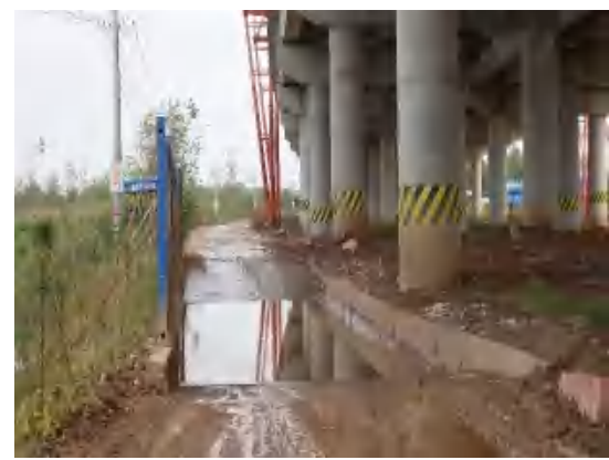
K20+400 施工便道车辆冲洗池
