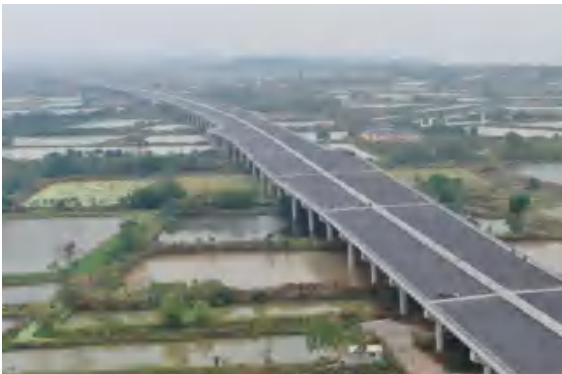
K31+400 原施工便桥拆除恢复，桥梁现状
