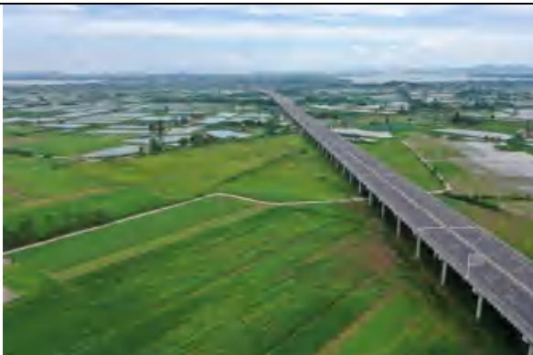
K31+000 施工场地绿化恢复现状
