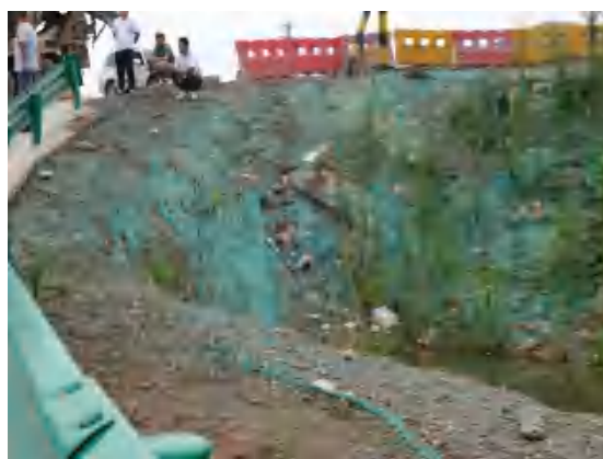
K20+600 拌合站及制梁场边坡防护网苫盖
