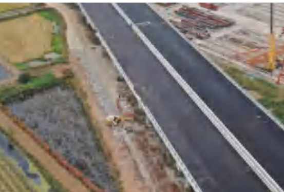
K26+900 施工便道硬化层拆除，平整恢复
