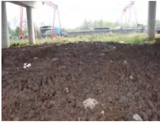
K20+600 桥下迹地土地平整
