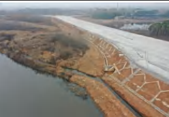
K19+500 红莲湖互通匝道路基填筑边坡人形骨架护坡防护，路基排水沟
