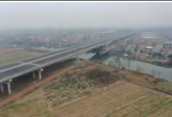
K30+150 施工便道、便桥拆除恢复
