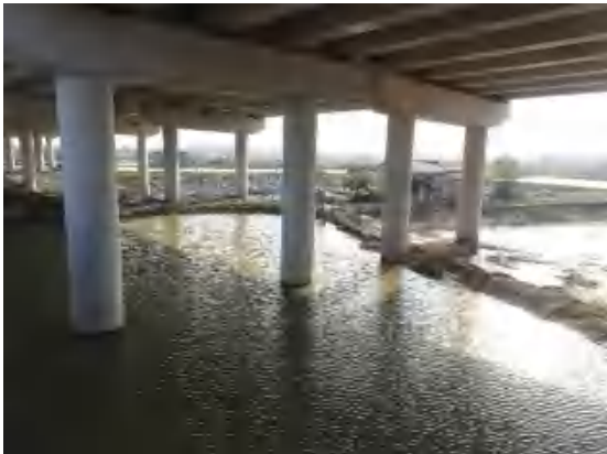
K33+600 长港河特大桥桥下恢复鱼塘
