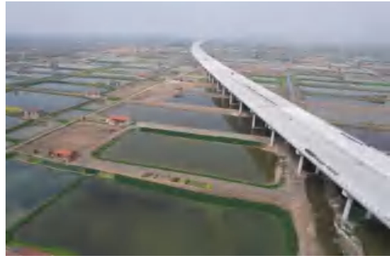
K33+600 桥梁施工占用鱼塘恢复现状
