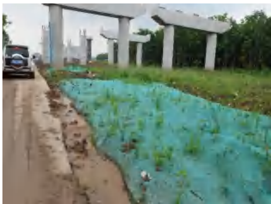
K29+300 桥下撒播草籽及土工布苫盖
