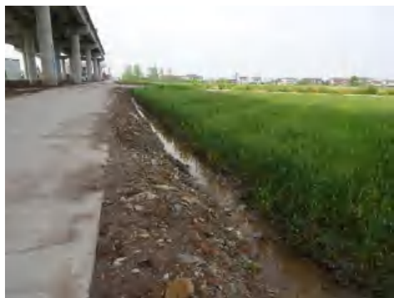
K30+800 混凝土施工便道临时排水沟
