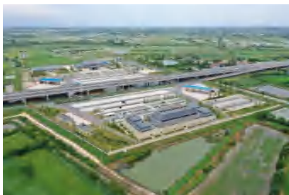
K22+350 梁子湖服务区场内以及填筑边坡绿化
