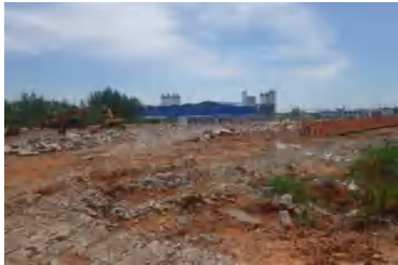
K20+500 桥梁预制场硬化层拆除恢复
