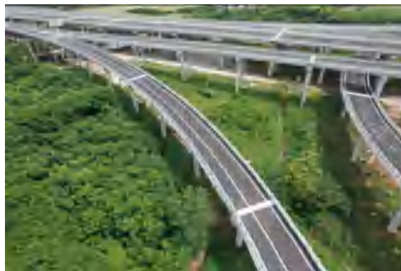
K25+590 长港互通内扰动范围以及填方路基边坡植被恢复
